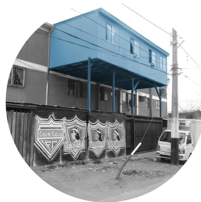
Figura 2. Ampliaciones Informales en Bloques de Vivienda Tipo C. Fuente: Sanhueza, J., 2019. Modificación Propia.
