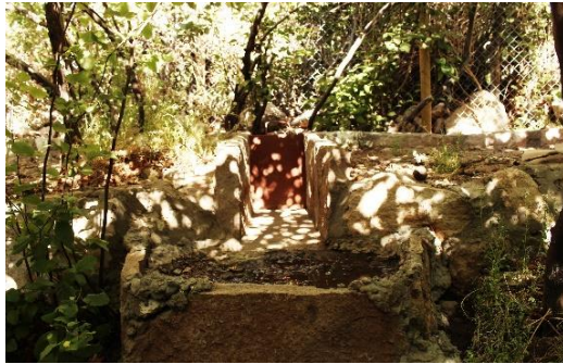
Fotografía 32: Este dispositivo que combina la mecánica con el agua es el responsable de regular el fluido en el canal. (Fuente: Araya P. 2017)
