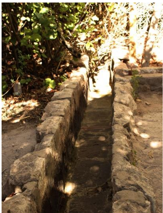
Fotografía 33: Este caudal además de transportar el agua, funciona como divisor del terreno, provocando una profundidad de unos 15-20cm (Fuente: Araya P. 2017)
